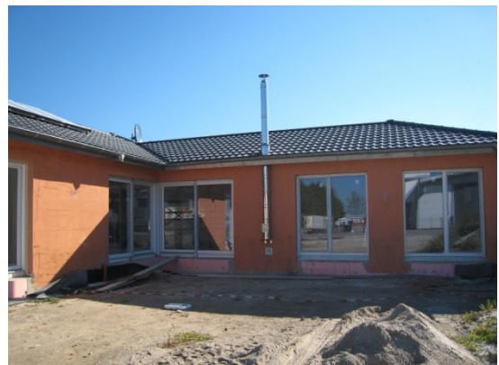
und der Kamin ist eingebaut.
