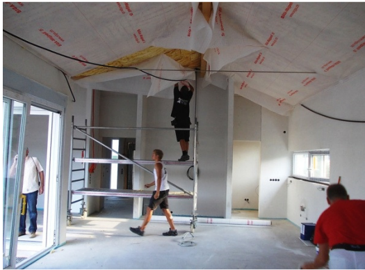
Der Innenausbau ist in vollem Gang.
