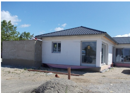
Die Außendämmung wurde angebracht...
