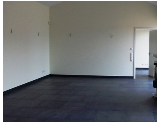
Die Bodenfliesen sind verlegt.
