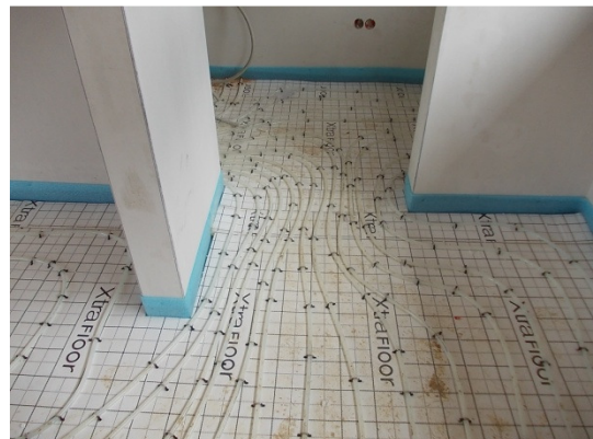
die Fußbodenheizung wird verlegt.
